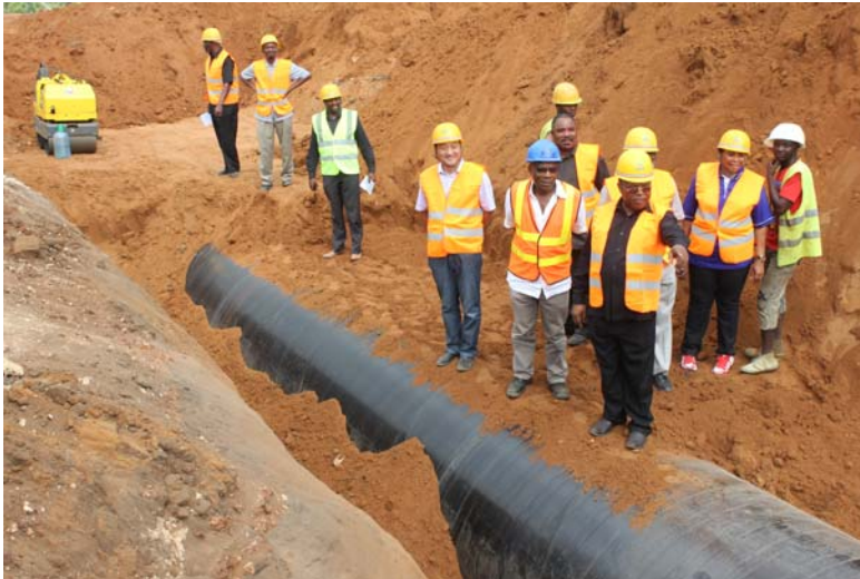
Waziri wa Maji, Mhe. Prof. Jumanne Abdallah Maghembe (Mb) akikagua ujenzi wa Mradi wa ulazaji wa bomba kuu la maji kutoka Ruvu Chini kwenda katika Jiji la Dar es Salaam mwezi Januari, 2014.
